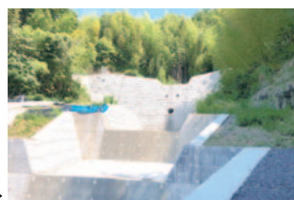
巴川水系 長尾南沢(静岡市葵区)のえん堤
