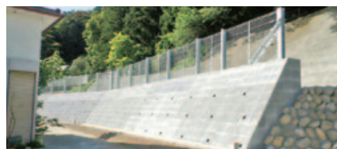
▲駿野急傾斜地(静岡市葵区)の擁壁(建物背後の壁と柵)と法面工(斜面を覆うコンクリート)
