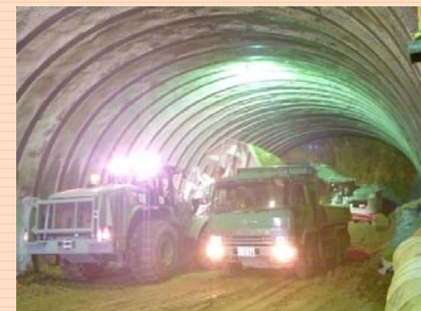
ズリ搬出 発破で砕いた岩をダンプに積みトンネルの外に出す作業です。
