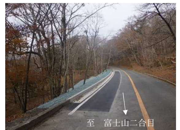
工事完了（4.2KP 付近）
