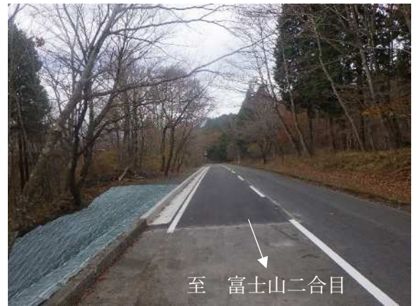
工事完了（3.8KP 付近）
