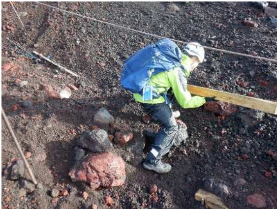
パトロールで異状を発見した場合は 補修作業を行います
