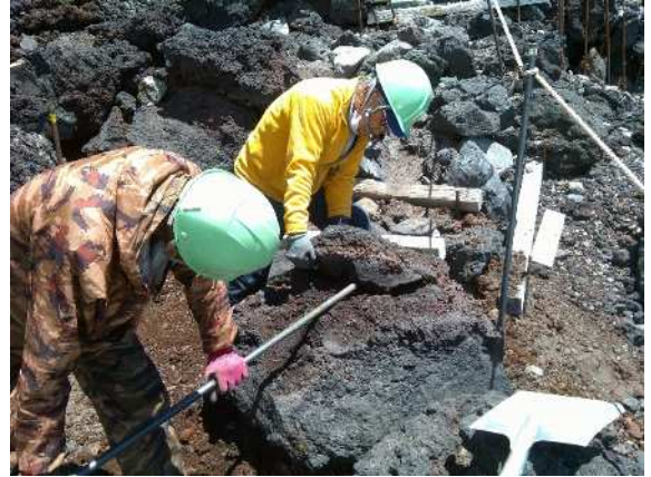
危険な転石を撤去
