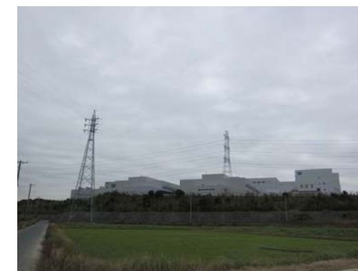
周辺部から地区内を撮影(南東向き)
