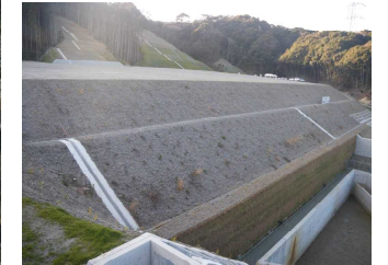
現場状況写真
