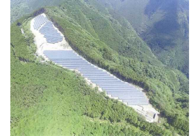
太陽光発電施設
