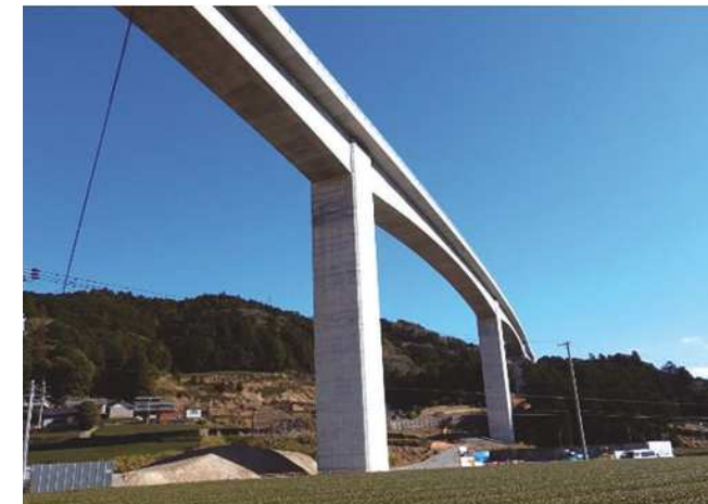
金谷御前崎連絡道路（国道473号）
