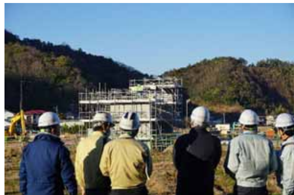
現場では、整備中の橋脚上に色彩パネルを設置し、実際の見え方をチェック
