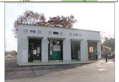
間伐材チップを活用するバイオマスプラント
