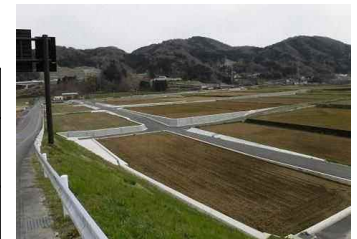
農業基盤整備完了
