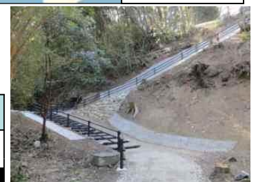
津波避難路となる観光遊歩道
