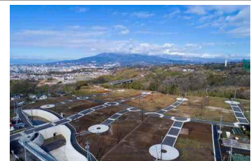
三島塚原地区住宅団地造成完了
