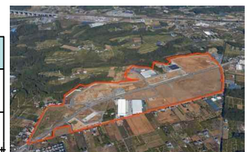
造成完了した第三都田工場用地
