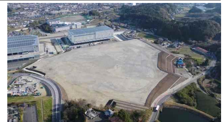
南西郷地区工業団地造成完了
