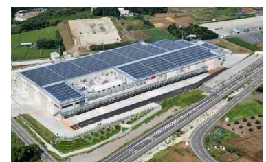
災害に強い物流施設
