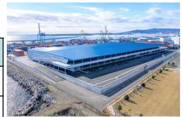
Lv2津波にも対応する物流施設
