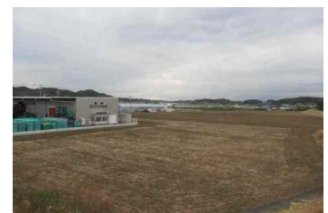
農地造成工事完了
