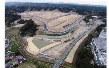
下野部工業団地造成完了
