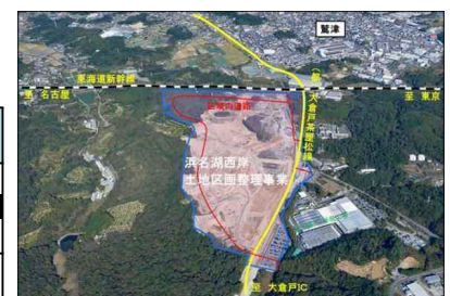
浜名湖西岸地区造成状況
