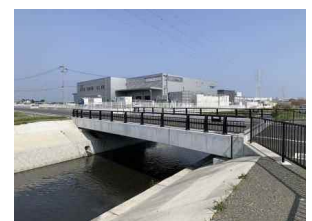
工業団地整備完了
