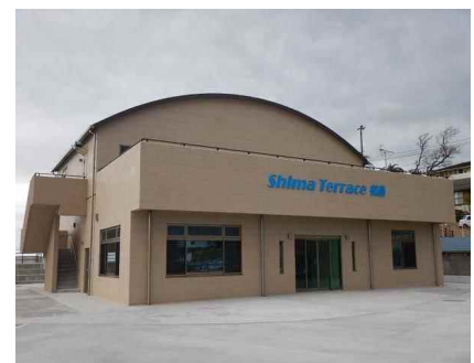
初島漁港交流広場・休憩施設完成
