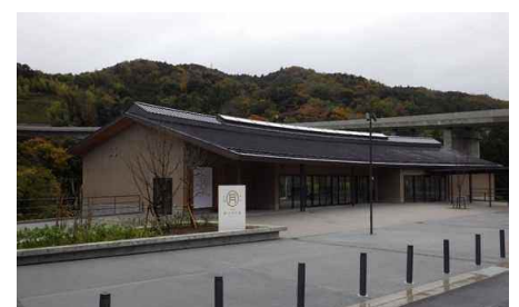
道の駅「伊豆月ヶ瀬」完成
