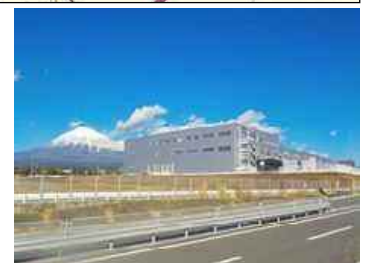
完成した大規模物流施設
