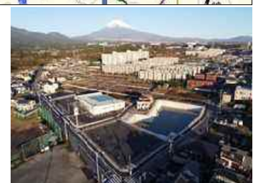
御宿地区住宅団地造成状況
