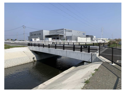
工業団地整備完了
