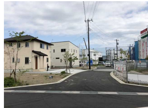
大場地区住宅団地
