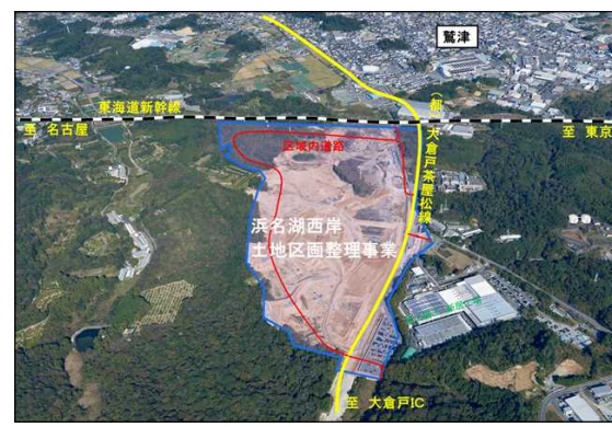
浜名湖西岸地区造成状況
