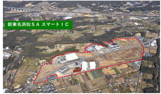
造成完了した第三都田地区工場用地
