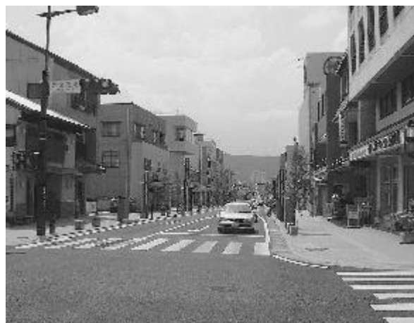
電線・電柱の地中化による景観整備（都市計画道路「西富士宮駅大宝坊線」）
