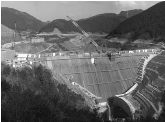
平成20年度の完成に向けて、建設が進む太田川ダム
