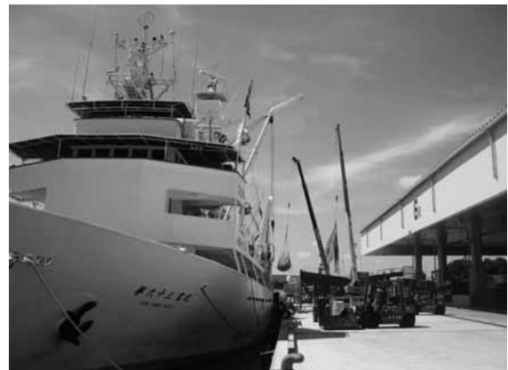
大型化する海外まき網船に対応した－9 m岸壁と荷捌き施設（焼津漁港）
