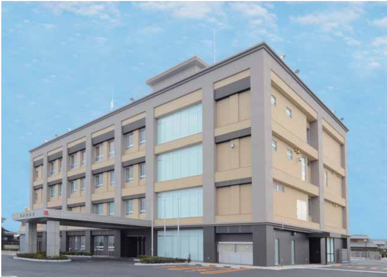
治安対策の拠点となる警察施設の整備（袋井警察署）
