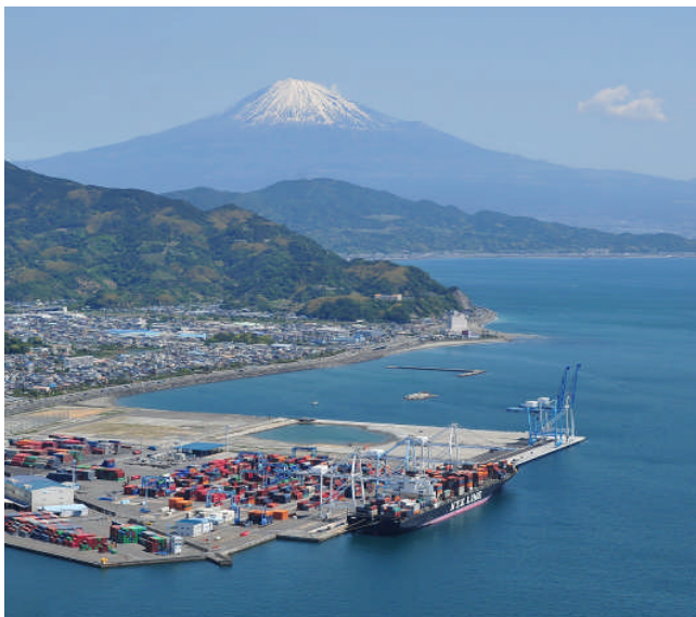
清水港新興津コンテナターミナル周辺
