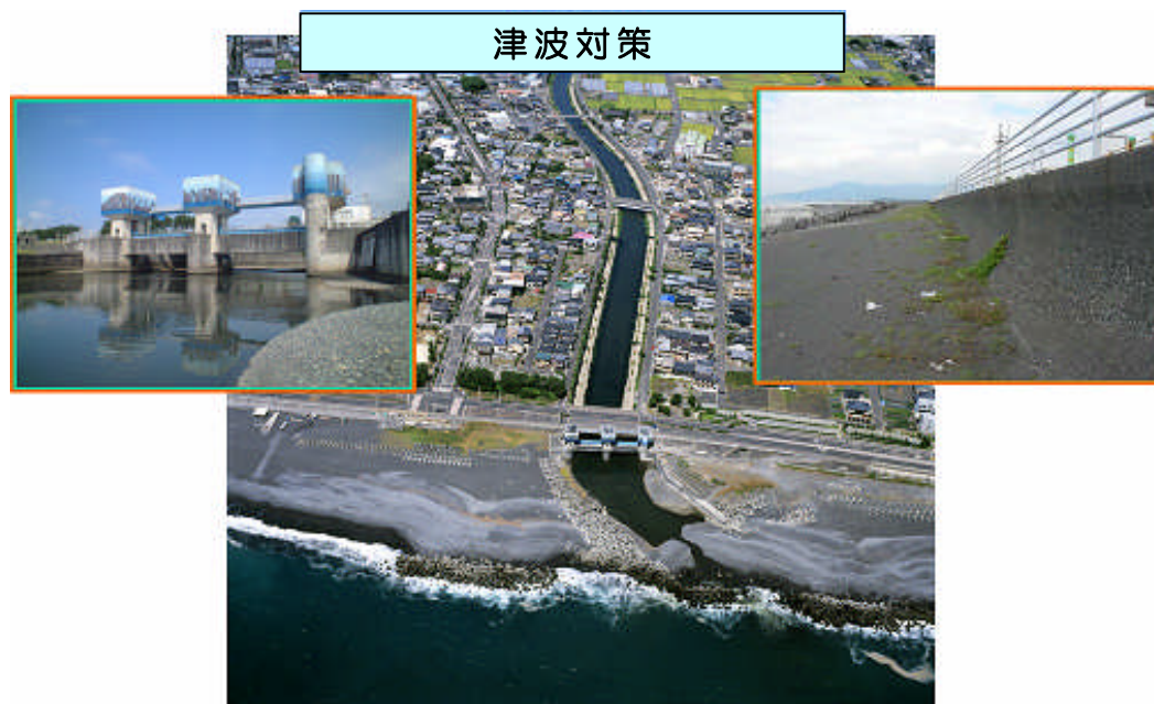
海岸に整備された水門と防潮堤（静岡海岸）
