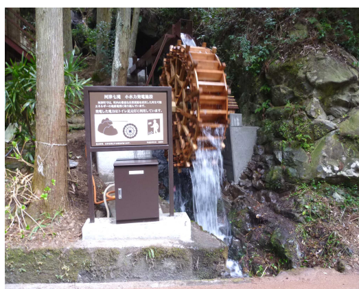
小水力発電(河津町)
