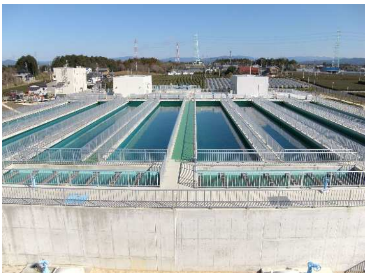
遠州水道 寺谷浄水場
