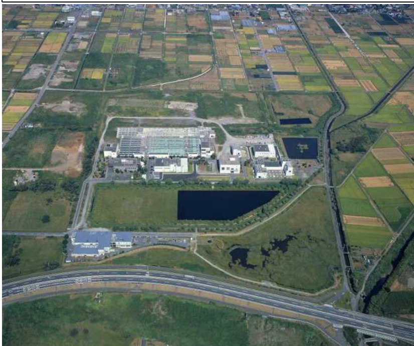
狩野川西部浄化センター
