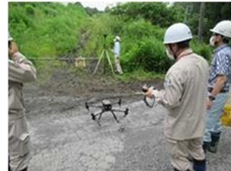
ドローンを用いた盛土の監視
