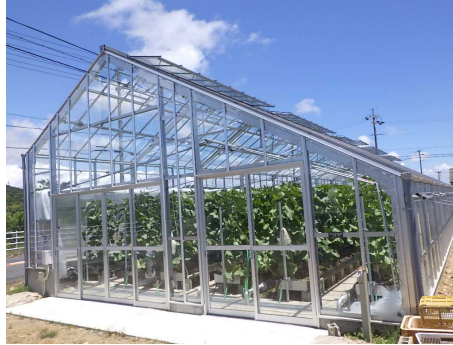
鉄骨ハウスの更新
