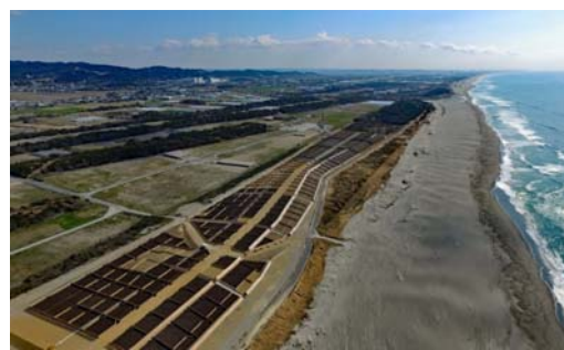
森の防潮堤整備
