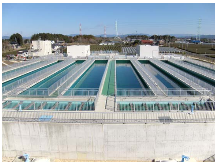
遠州水道 寺谷浄水場
