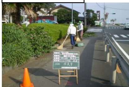
県道の維持補修
