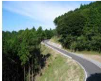
< 林道整備工事完了箇所 >
