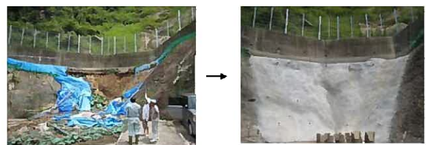
【西伊豆町の豪雨災害での応急復旧状況】
