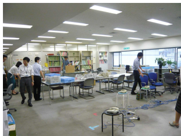
1日目(10/11)既存什器撤去
