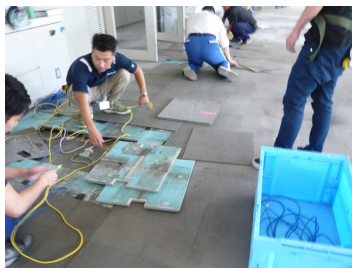
2日目(10/13) 配線工事
