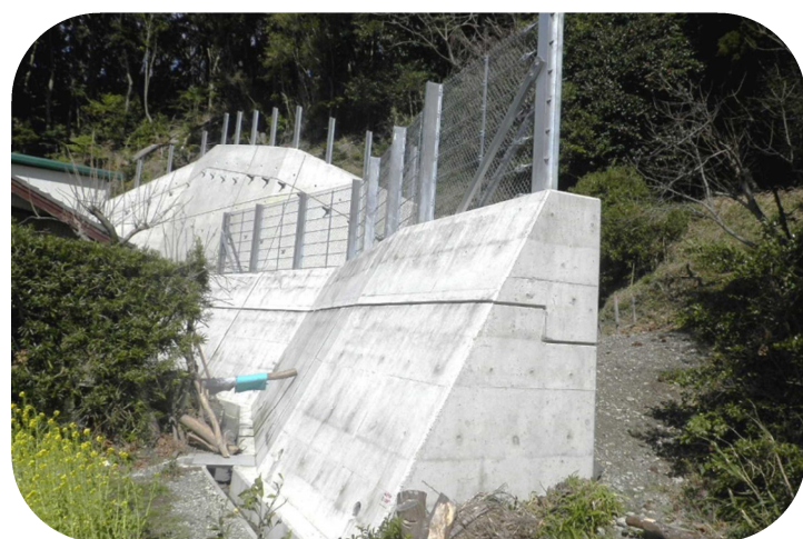
急傾斜地崩壊対策
