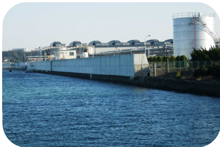
御前崎港海岸防潮堤
