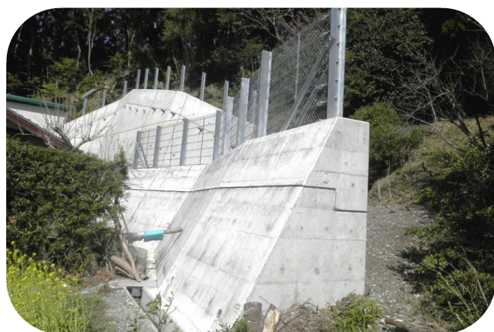
急傾斜地崩壊対策
