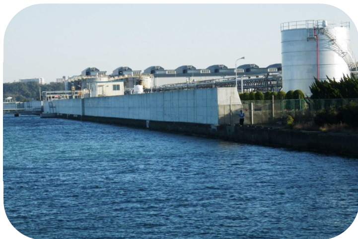
御前崎港海岸防潮堤
