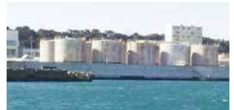
御前崎港防潮堤(胸壁)
