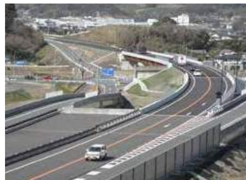
金谷御前崎連絡道路 菅山IC 付近
