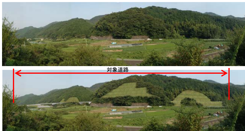
⑥下田街道（口村集落）より稲梓川沿いの耕作地を望む〔橋梁・高架〕
