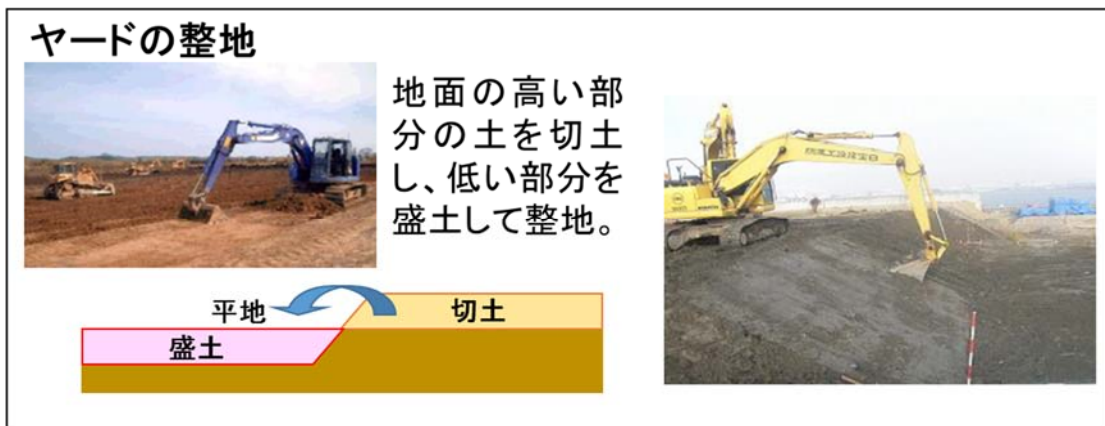
図 1-3 ヤード整地（写真は類似工事の例）
