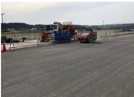
路面清掃状況
