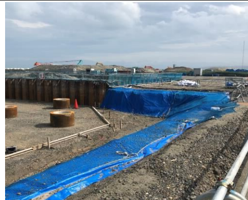
濁水発生防止対策状況
