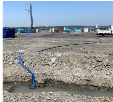
建設工事排水状況
