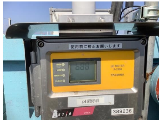
工事排水監視状況（pH）
