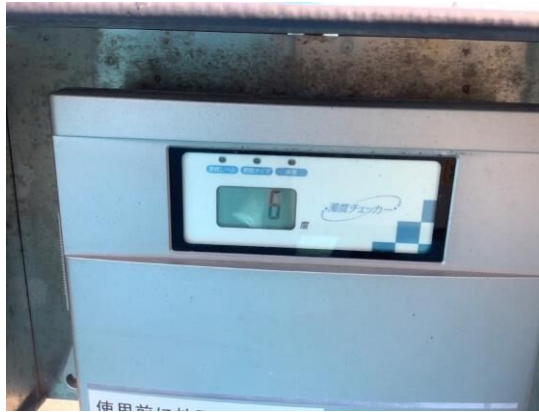
工事排水監視状況（濁度）
