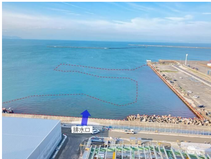
図 7-4 錆水の排水状況
