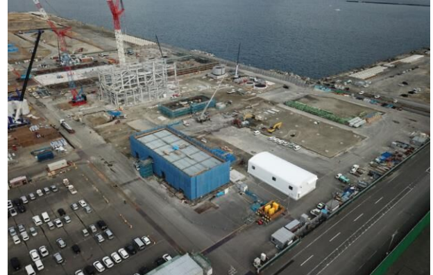
アスファルト舗装流用状況
