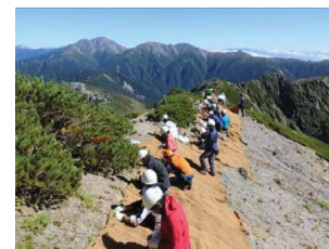
<南アルプスの自然> 塩見岳山頂付近(標高約3000m)での植生マット敷設>
