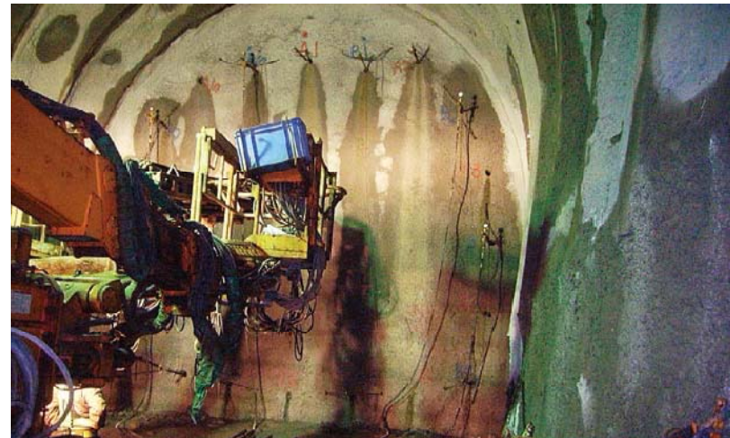
写真 薬液注入工の施工例
