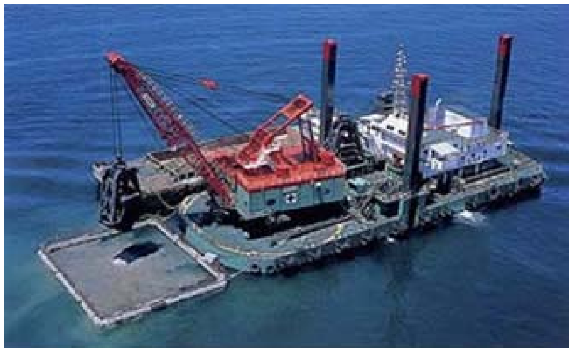
浚渫船による浚渫状況
