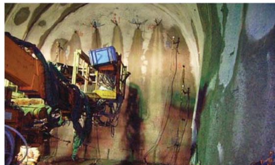
写真 薬液注入工の施工例
