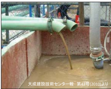
トンネル工事で発生する原水(濁水)
