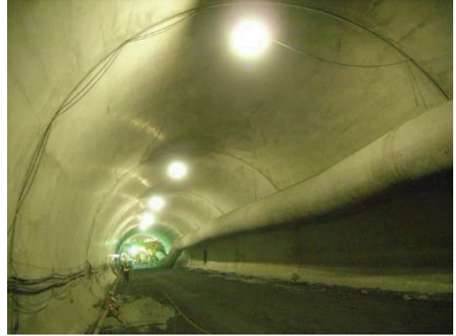
写真 覆エコンクリートの施工例 (一般県道 常神三方線 神子トンネル)
