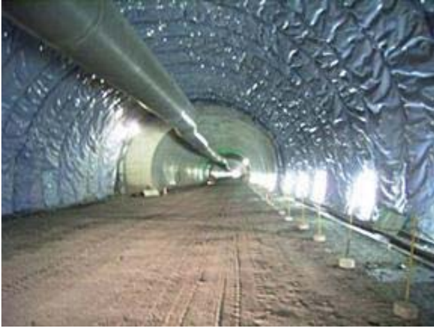
写真 防水シートの施工例 (一般国道191号線 萩・三隅道路)
