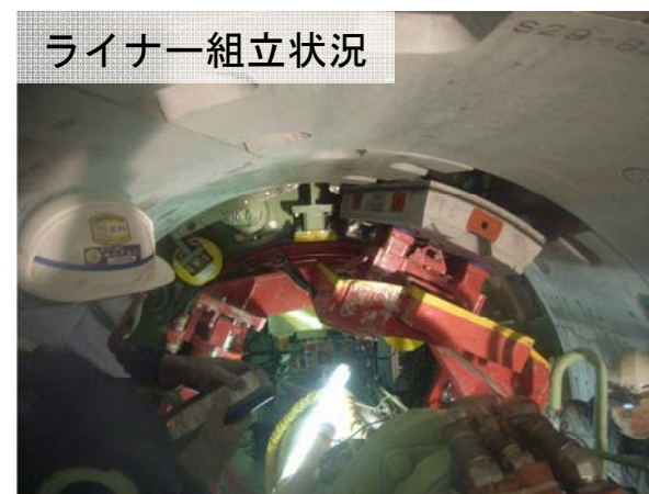
写真 TBMを用いた施工状況
