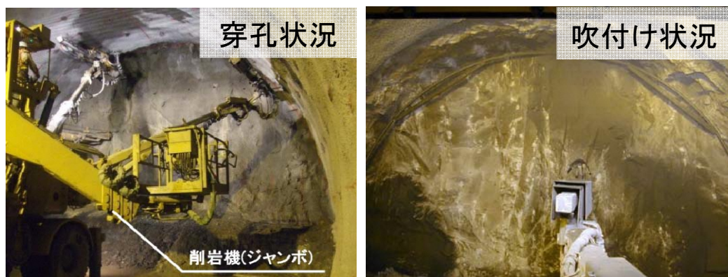
写真 NATMによる施工状況
