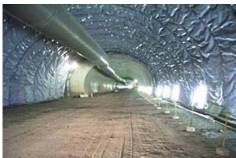
写真 防水シートの施工例
