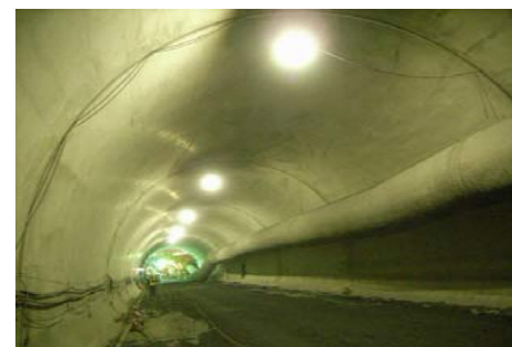
写真 覆工コンクリートの施工例
