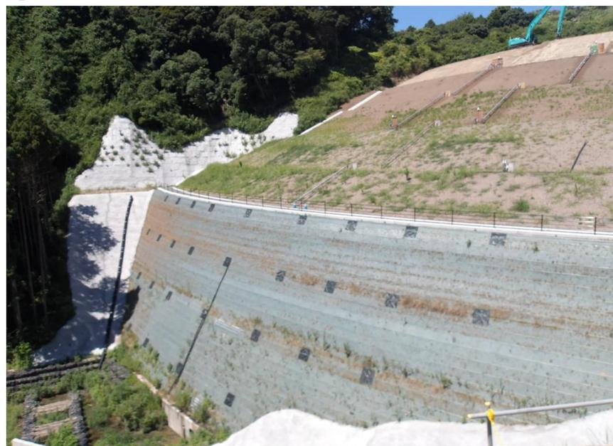
RESA整備工：上載盛土5段目施工中
