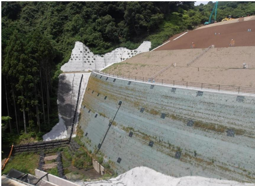
RESA整備工：上載盛土5段目施工中
