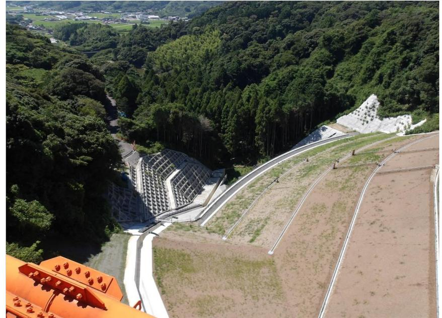
RESA整備工：上載盛土5段目施工中
