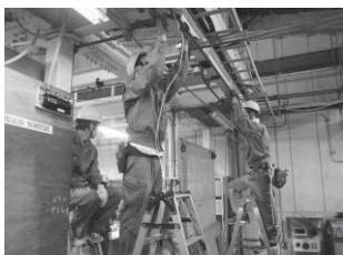
〔電気技術科〕 金属管工事及び ケーブル配線実習
