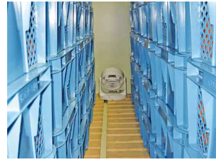
写真3 貯蔵庫内へのサーキュレータ設置状況
