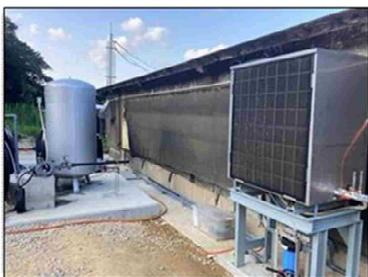
写真1 地下水利用型の冷房装置
