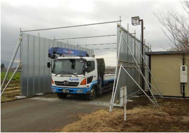
当所に設置した車両消毒装置
