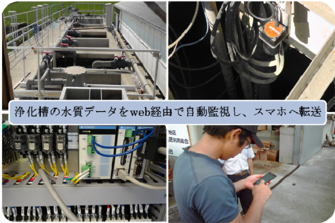
図 排水処理自動監視制御システム
