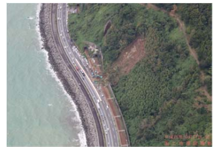
東海道本線由比-興津駅間の山腹が崩壊(静岡市清水区興津東町)
