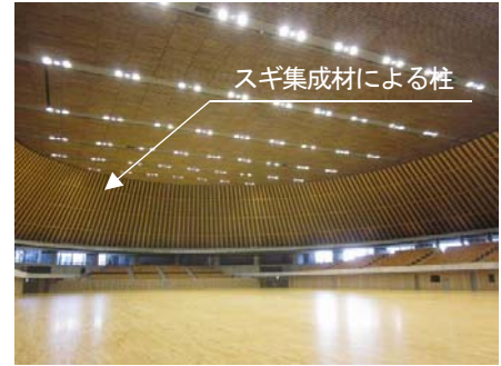
スギ集成材による柱 256本の柱が天井を支える木造体育館「このはなアリーナ」（静岡市駿河区栗原）
