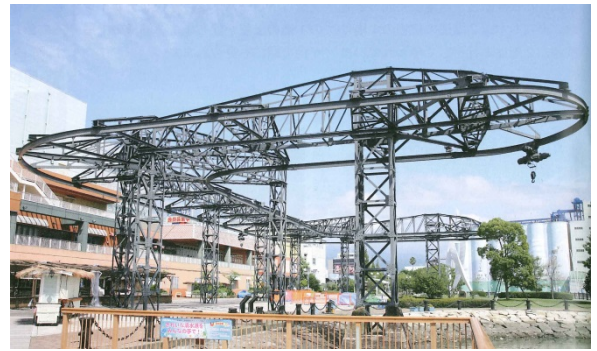
清水港テルファー(旧国鉄清水港線清水港駅に建設された木材積み込み用クレーン)(静岡市清水区新港町)
