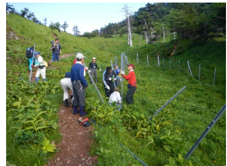
南アルプス・聖平周辺における防鹿柵修繕作業（静岡市葵区田代）
