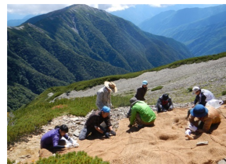
南アルプス・塩見岳山頂直下での植生マット敷設作業（同上）
