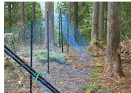
試験で施工した斜め張りネット (同上)
