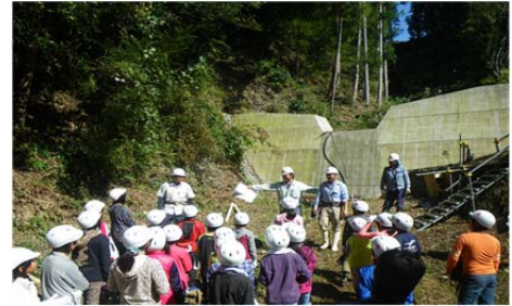
徳山建設(株)による治山工事体験 (榛原郡川根本町水川)
