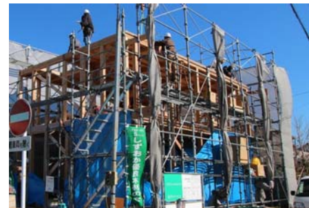
天竜材を使った住宅(掛川市弥生町)
