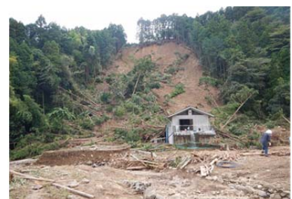
山腹崩壊により、水道施設や市道が被災(静岡市清水区小河内)
