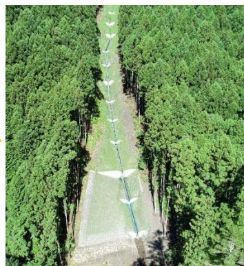
治山事業による山腹崩壊地の復旧 (浜松市天竜区春野町)
