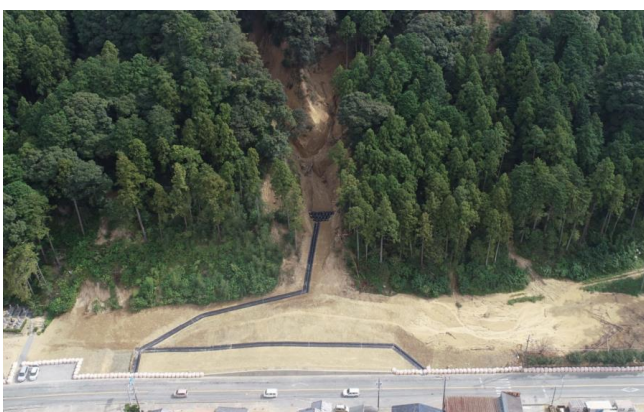
磐田市神増 応急復旧工事完了後の状況
