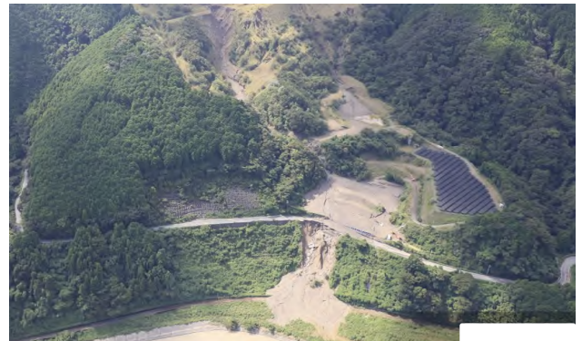
島田市福用の土砂流出状況（提供：(株)パスコ/国際航業(株)）
