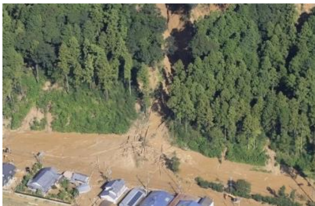
磐田市神増の被災状況 (提供：(株)パスコ/国際航業(株))
