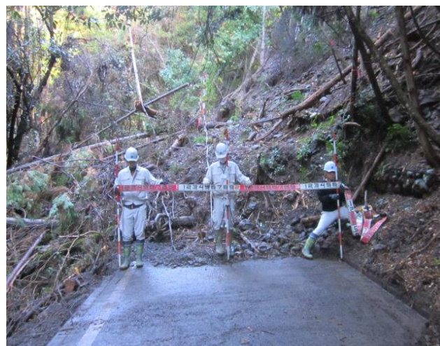
林道前谷線の被災状況 (浜松市天竜区只来)
