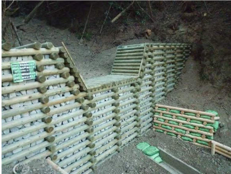
近景（静岡市小河内）
