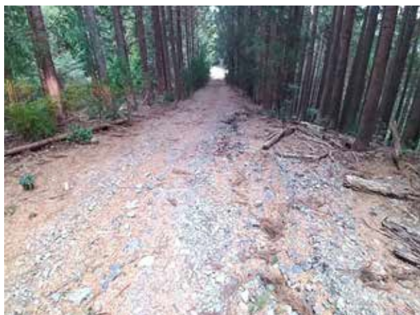
路面整正（整備前）
