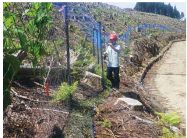
防護柵の補修
