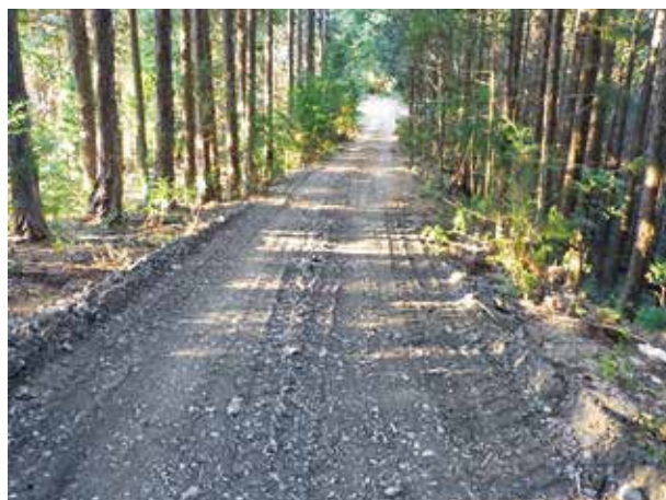
路面整正（整備後）
