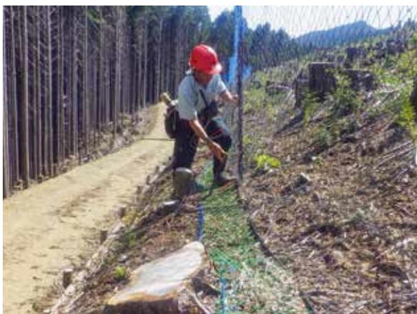
防護柵の点検
