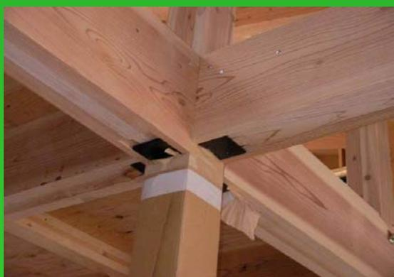
スギ合わせ梁桁と柱の
