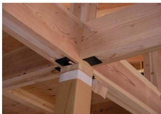
梁桁に使用された積層接着合わせ梁
