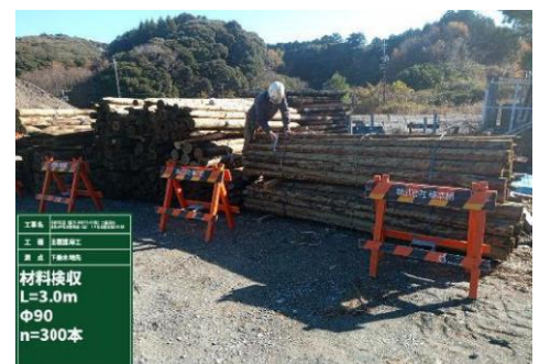
【木杭規格確認】
