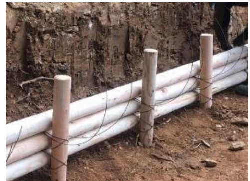
【設置作業状況】
