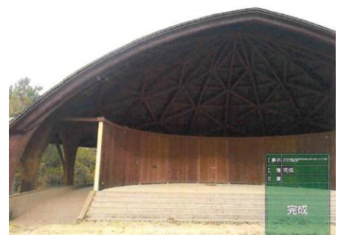
【板材交換(左手側)】
