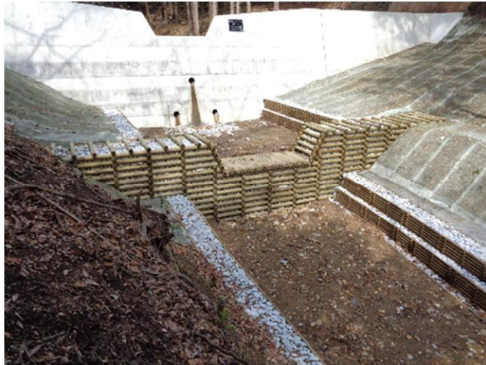
【木製校倉式ダム工(副堤)】
