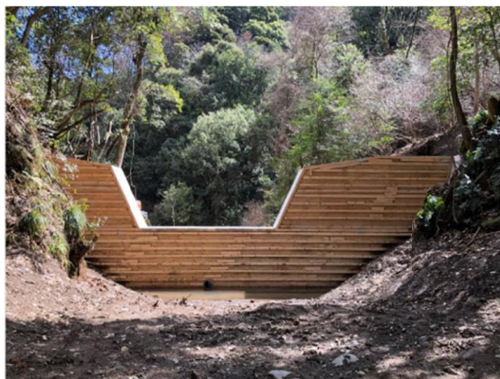
【上流残存型枠】
