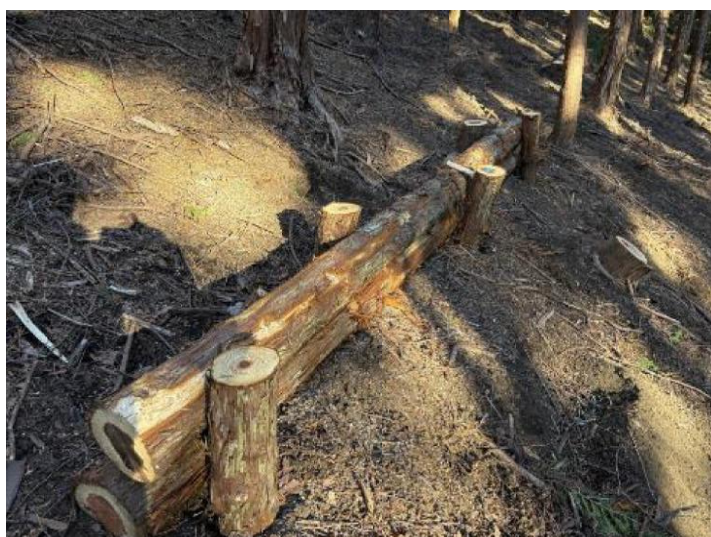
【現地発生材を利用した簡易木製構造物】
