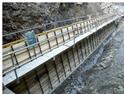
【護岸工】型枠＋残存型枠
