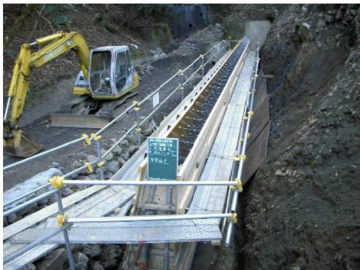
【護岸工】 型枠＋残存型枠
