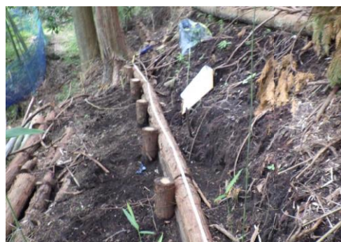
【丸太筋工】藤曲地区
