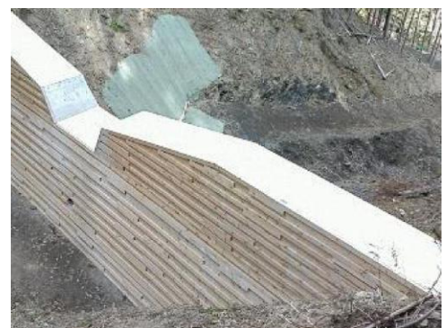
【残存型枠(カチオンフレーム)】右岸側
