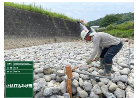
【止杭打込み状況】
