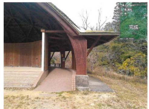
【板材交換(右手側)】
