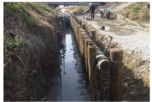
【木杭設置状況】
