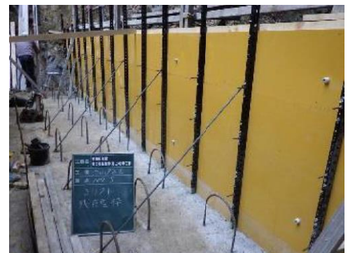
【型枠組立完了】
