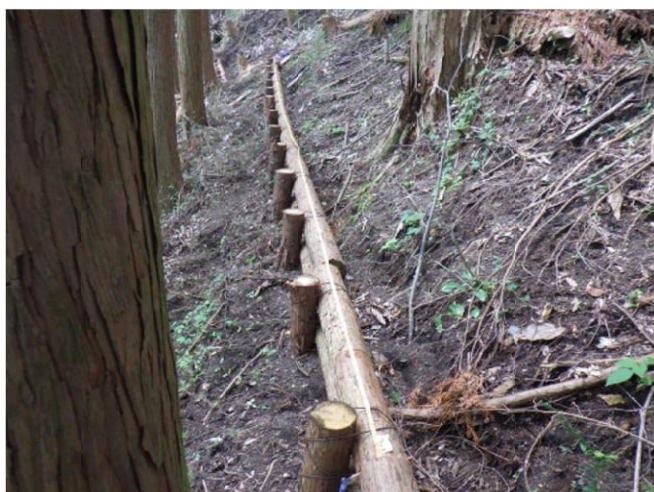
【丸太筋工】中島地区
