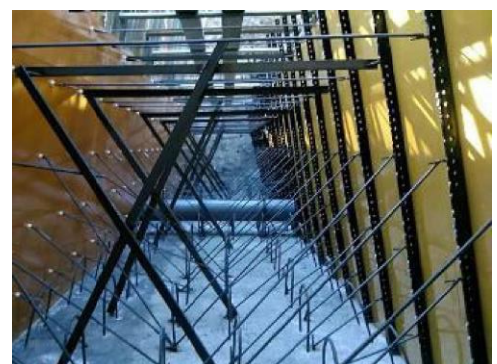
【残存型枠(カチオンフレーム)】施工状況
