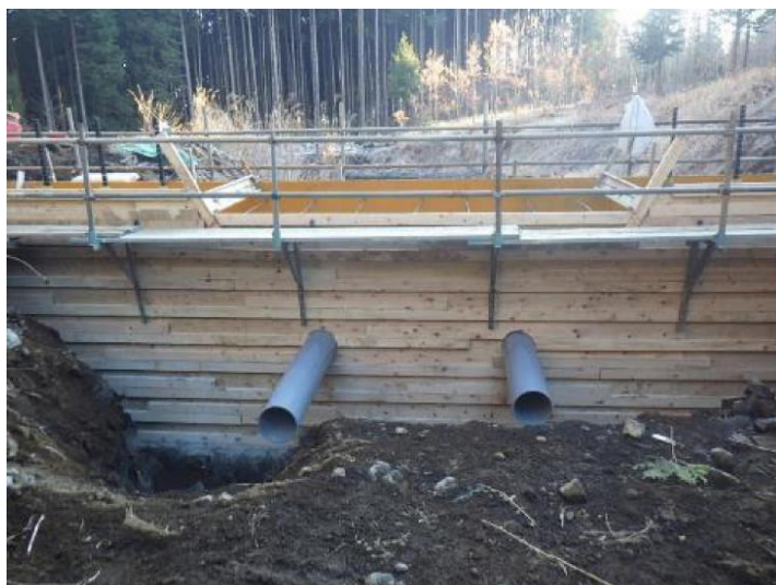
【治山ダム合板型枠】
