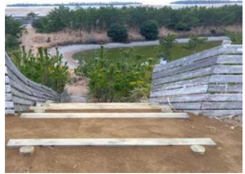
【上部】 雨水対策のため嵩上げ
