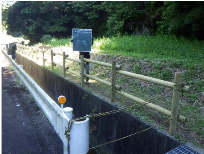
【転落防止柵 更新完了】
