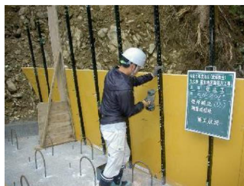
【谷止工】 型枠組立状況
