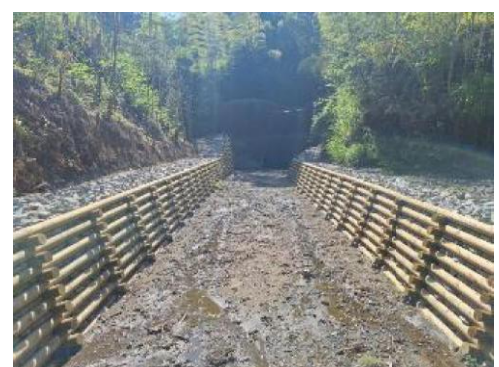
【木製校倉式流路工】
