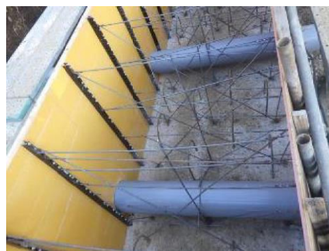
【内観施工状況】
