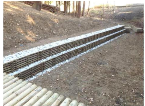
【高耐久性木製枠工(ユニット式)】左岸
