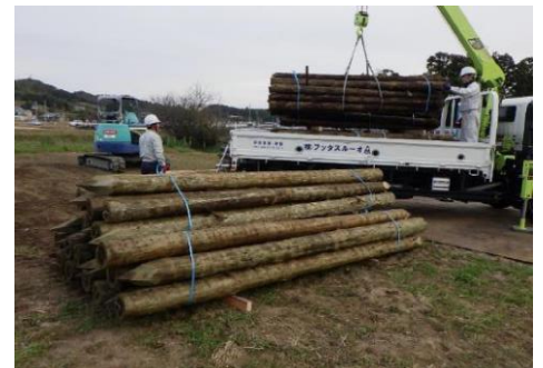
【木杭規格確認】
