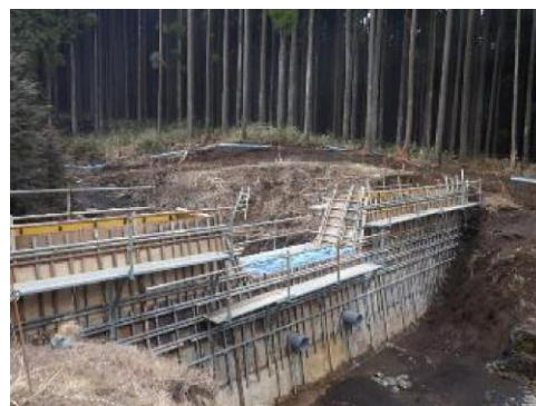
【背面施工状況】
