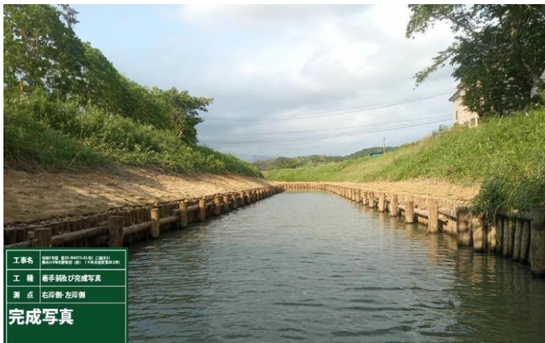
【木柵工事完了】
