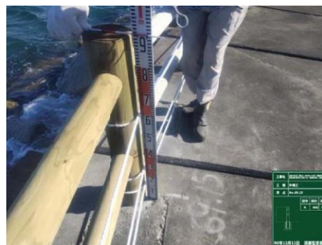
【木柵支柱設置状況】
