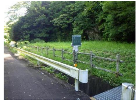
【転落防止柵 更新前】
