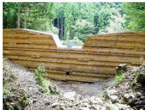
【谷止工】 残存型枠
