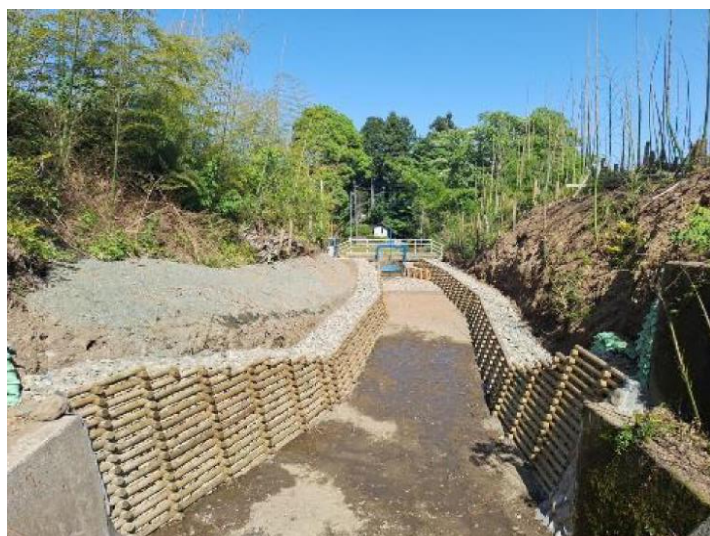
【木製校倉式流路工】
