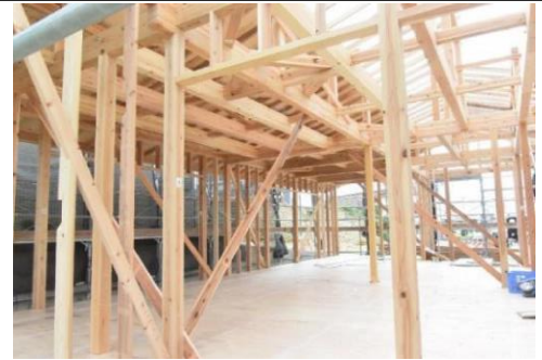
【建設中の様子】
