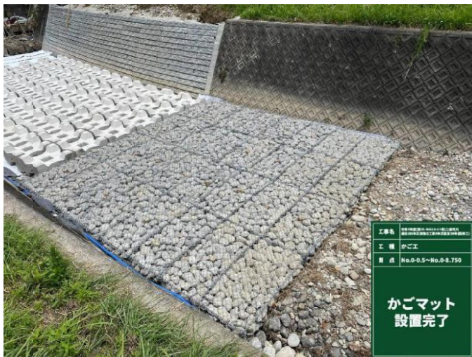
【かごマット設置完了】
