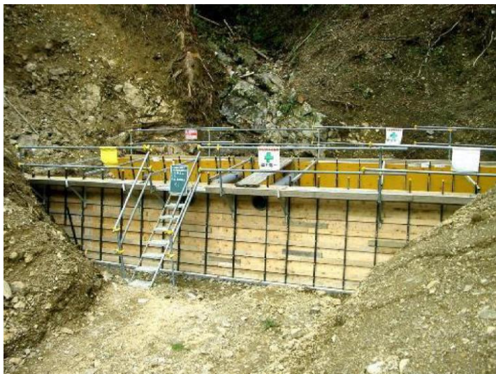
【谷止工】 型枠＋残存型枠
