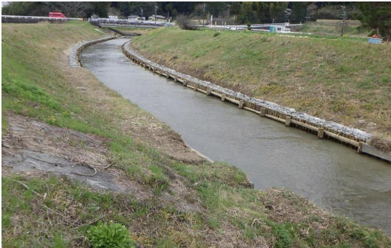
【木柵工事完了】
