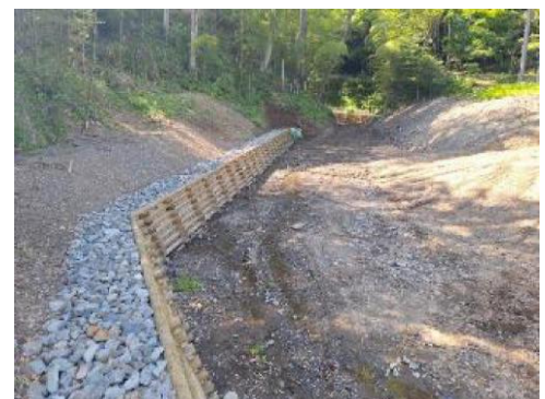
【木製校倉式護岸工】
