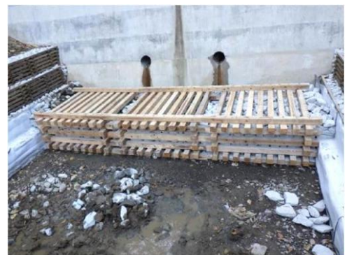
【木工沈床工】本堤水叩き部
