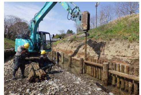
【木杭設置状況】
