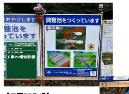
【工事PR看板】
