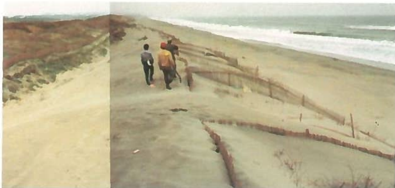
堆砂工の施工によって堆砂した状況。
