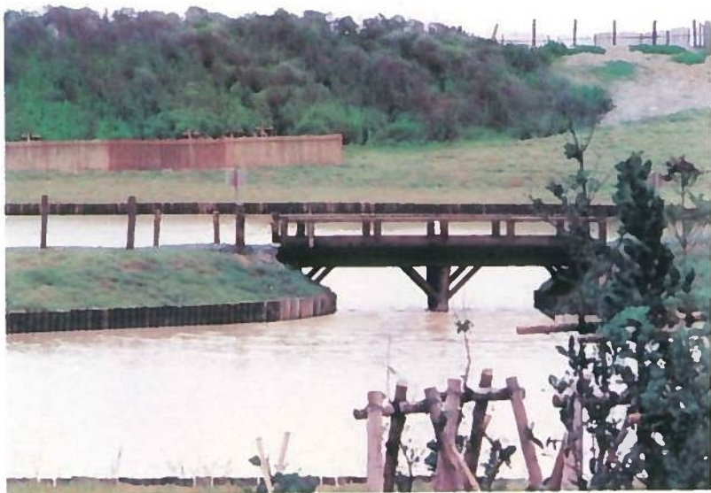
地下水を利用した貯水工
