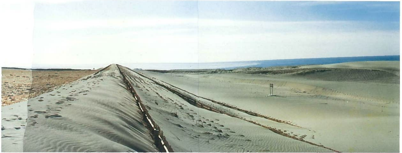
人工砂丘 (延長216m) 後方は覆砂工 (むしろ伏) ← 冬期主風
