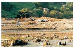
伊豆急稲梓駅付近 被害状況
