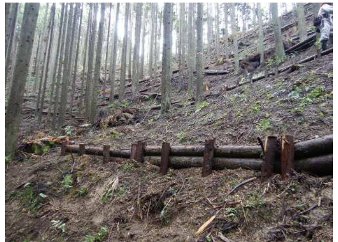
伐採木を使用した筋工 (浜松市天竜区横川)
