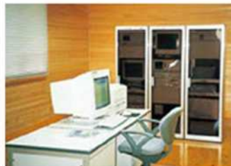
観測データの集積・転送 （由比地すべり管理センター）
