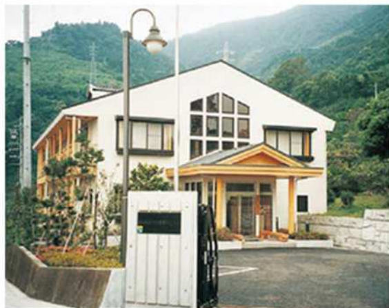
由比地すべり管理センター外観
