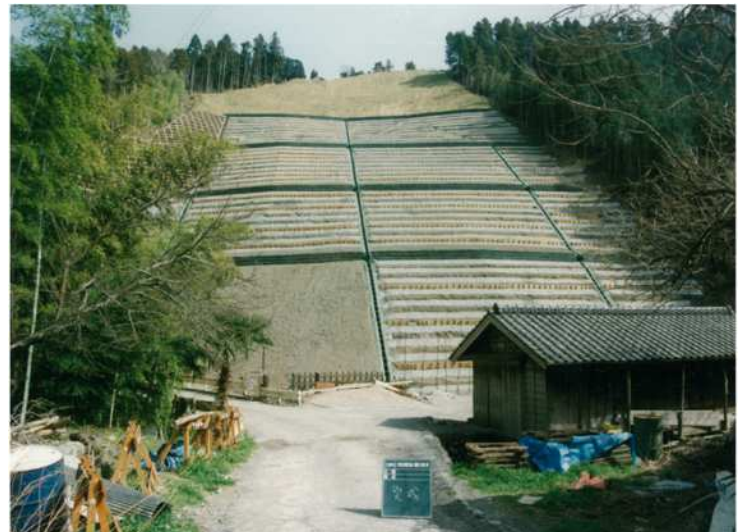
柵工・伏工（山腹工） 静岡市清水区和田
