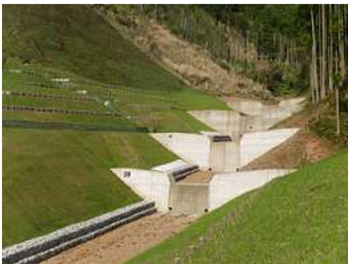
治山ダム（溪間工） 賀茂郡河津町梨本
