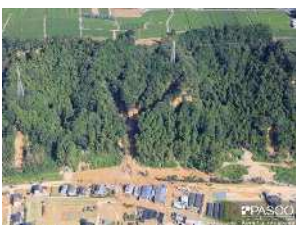
磐田市神増 土砂流出状況
