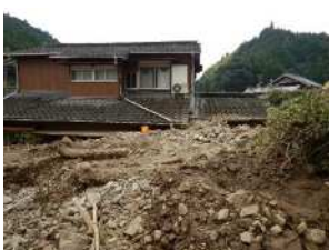
静岡市清水区布沢 被害状況
