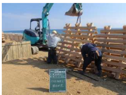
強風等から植栽木を保護する 防風工の設置
