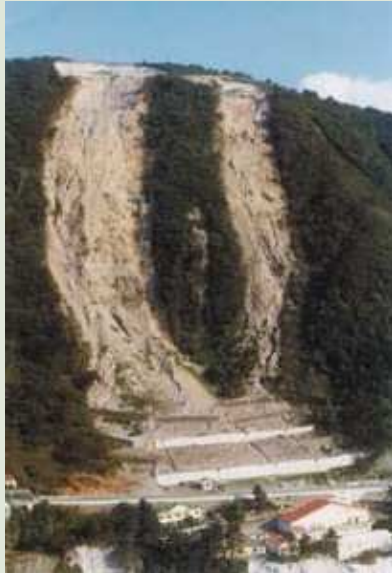
工事着手当時の状況（東伊豆町白田）
