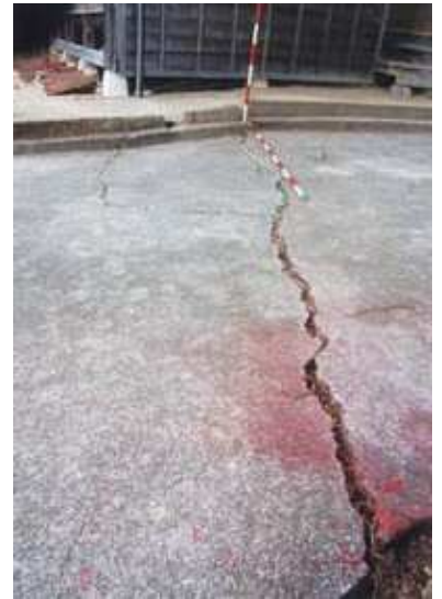
地すべりによる家屋被害
