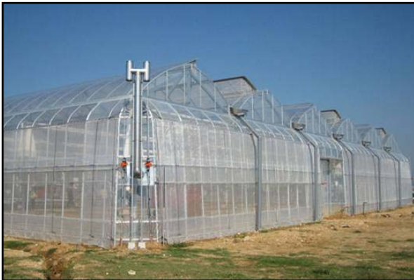
低コスト耐候性ハウス（風速 50m/s に耐える）
