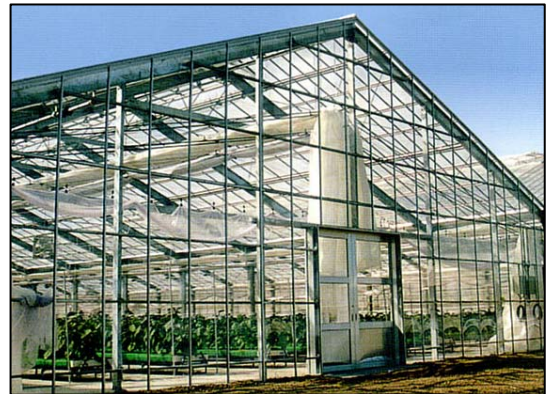
両屋根型鉄骨ハウス
